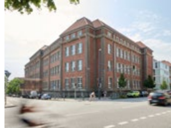
Fachbereich Technik, Ecke Knooper Weg/Legienstr. (o. l.), Fachbereich Landbau in Schleswig, Bellmannstr. 26 (u. l.)
