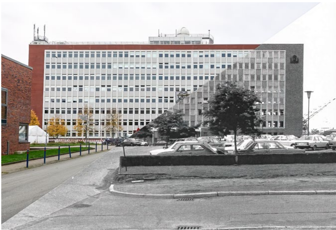
Im einstigen HDW Verwaltungsgebäude sind heute die beiden größten Fachbereiche der FH Kiel, Wirtschaft sowie Soziale Arbeit und Gesundheit, zuhause.
